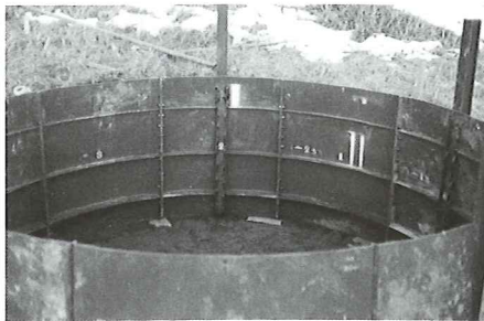
写真3 開発されたカプセル工法(このシューの中で掘削し、ライナープレートを組み立て、順次油圧ジャッキで圧入、掘削、ライナープレート組み立てを繰り返す)
